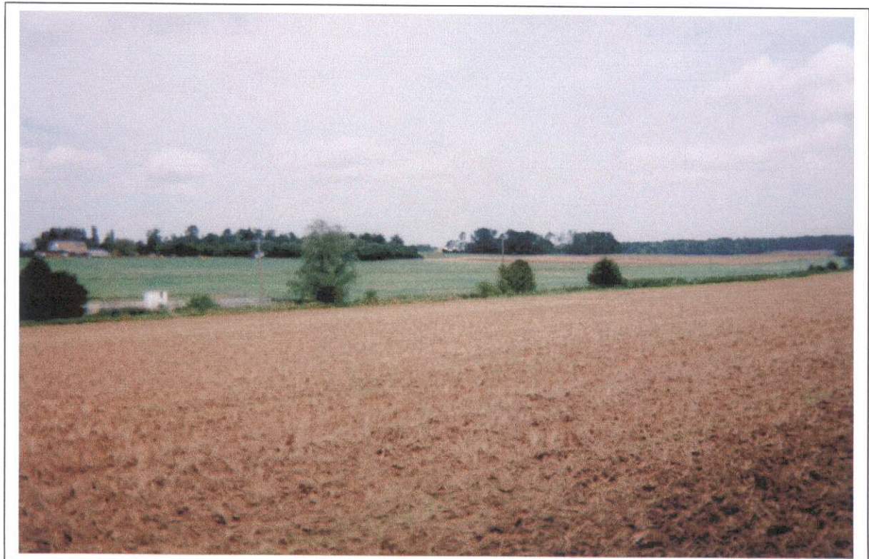
Photo n° 6 : Station d'épuration d'Orvilliers
